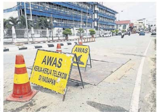
■轻快铁第3干线计划重启后，工程近日又如如火如荼展开，巴生地区的其中一项工程便是提升地下电缆和水管。
