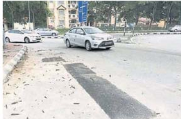
■巴生北区市区一带早前也有提升工程，事后这些曾被挖开的“主洞”，全都重新铺上沥青。
